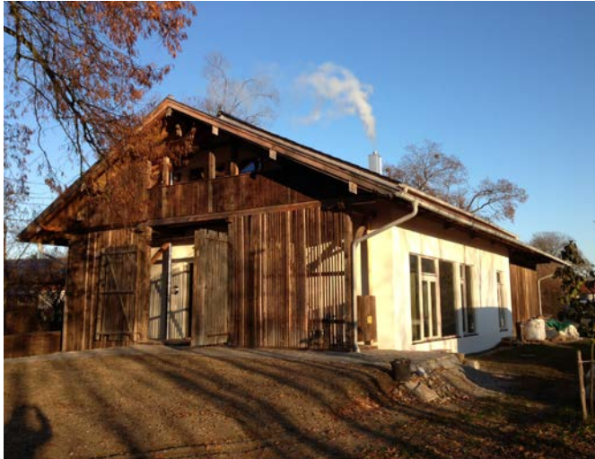
Abb. 1a und b: Mit Holzweichfaser, Zellulose, Lehmsteinen und Lehmputzen umgebauter Stadel in Bayern.
