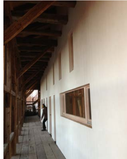
Abb. 1a und b: Mit Holzweichfaser, Zellulose, Lehmsteinen und Lehmputzen umgebauter Stadel in Bayern.
