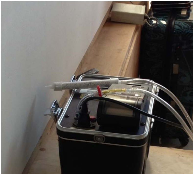
Abb. 2: Thoron-Messungen des Helmholtz-Institutes am bayerischen Stadel. Trotz Messung in 3 cm Abstand wurde an den fertiggestellten Wänden keine signifikante Thoronausgasung festgestellt. Die dort verwendeten Materialien und Wandaufbauten sind repräsentativ für den Lehmabau in Deutschland.
